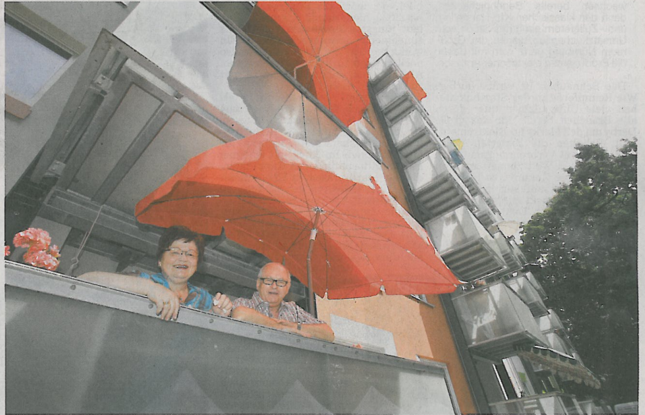
Viele Mieter in der Schultheißallee 34-38 sind glücklich über das modernisierte Gebäude. Sie sparen dadurch auch Energie ein. Auf der anderen Seite aber hat die wbg nach der Sanierung auch die Miete erhöht. Foto: Michael Matejka
