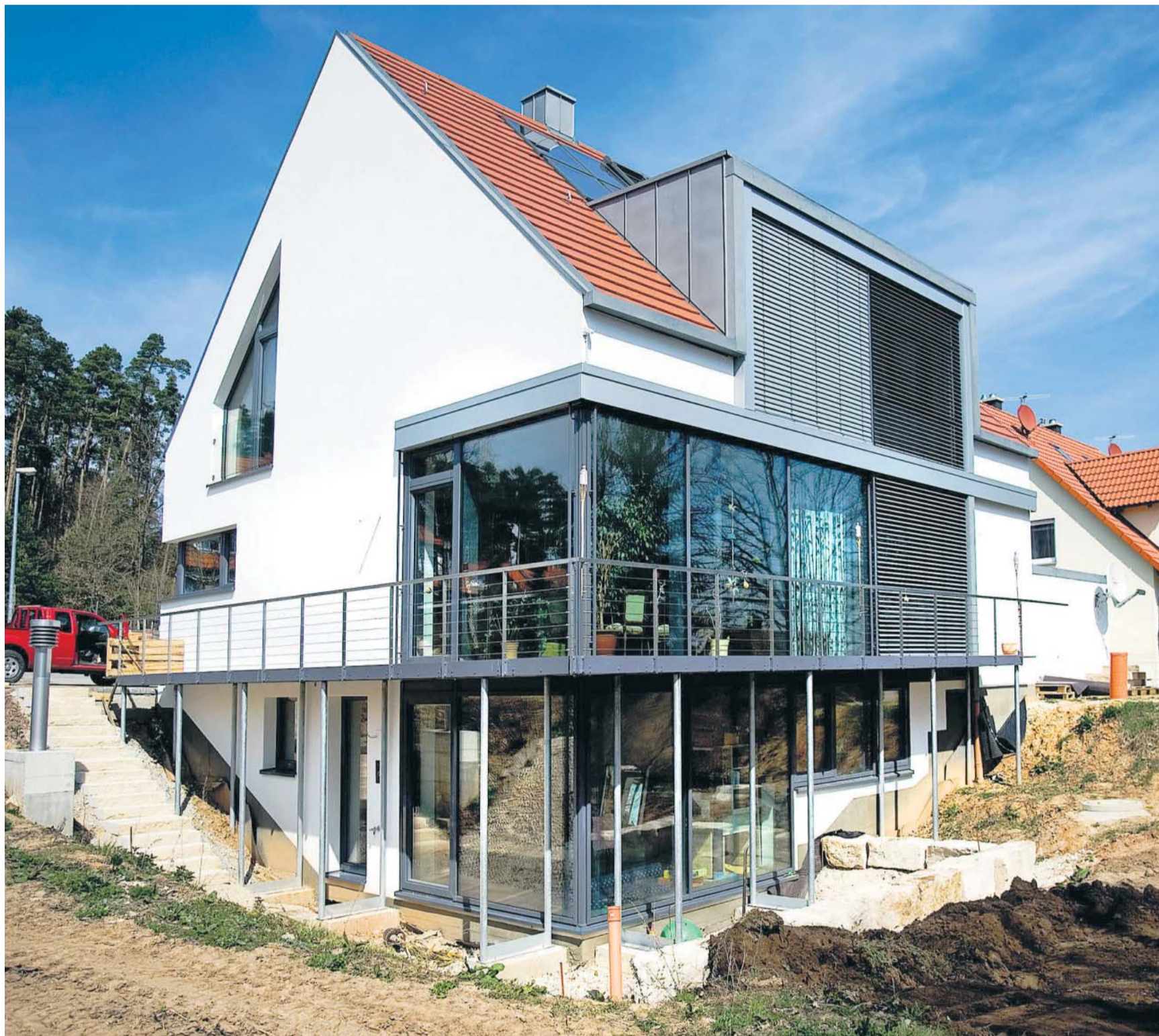
Ein typisches Passivhaus mit vielen Fenstern zur Südseite. Links das Ansaugrohr für die Frischluft im Haus
