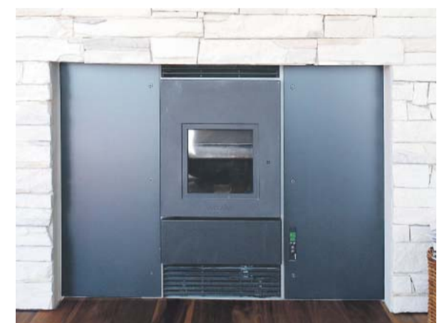
Ein Holzpelletsofen sorgt für zusätzliche Wärme
